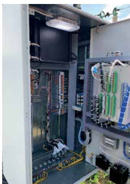
Рис. 6–9. Микропроцессорный комплекс определения места повреждения при всех видах замыканий на линиях 35 кВ
