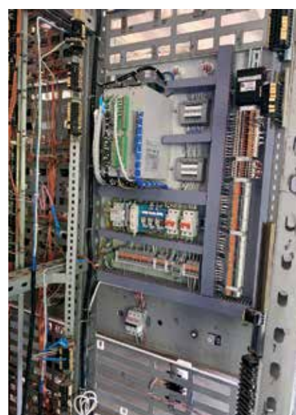
Рис. 6–9. Микропроцессорный комплекс определения места повреждения при всех видах замыканий на линиях 35 кВ
